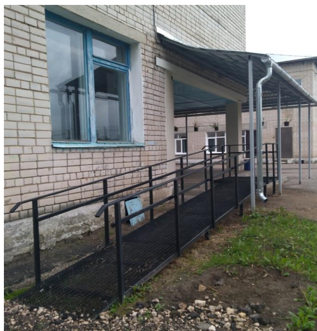
Пандус при входе в школу
